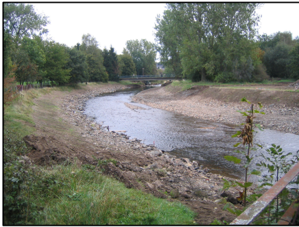
Umlegung und Renaturierung der Inde in Eschweiler/Weisweiler
