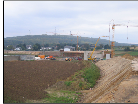
Bau der B 264n und der L 11n in Weisweiler
