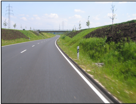
Bau der L 238n (Aldenhoven)
